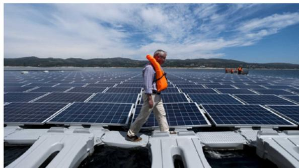
En effet, l'installation des panneaux sur un milieu aquatique présente plusieurs avantages : cela refroidit les cellules dont le rendement augmente de 4 à 10% ; il n'y a pas besoin d'utiliser des terrains ni de construire des lignes électriques supplémentaires. De plus, la centrale flottante réduit l'évaporation du réservoir et limite la prolifération des algues, signalent les responsables du projet d'EDPR.
