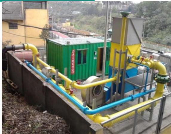
FIGURE 4. STATION DE DRAINAGE DE MÉTHANE À KHE CHAM
