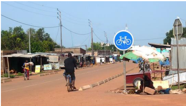
Un piste cyclable séparé avec des pierres à Ouagadougou, Burkina Faso.
