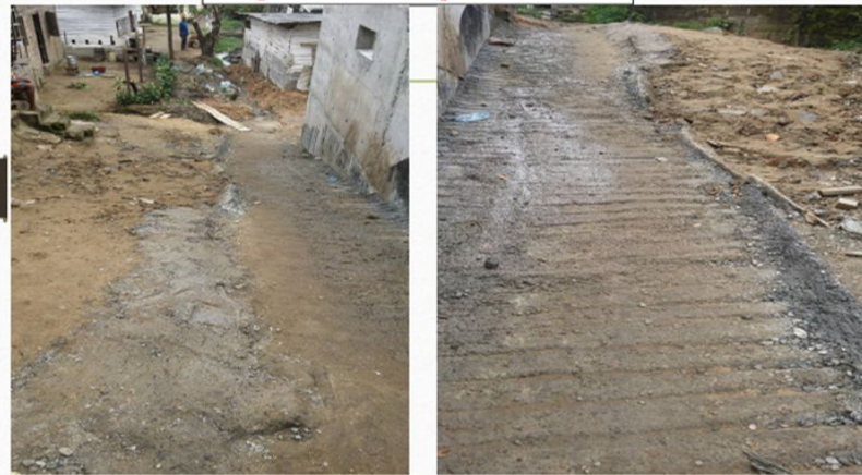
Image d'une ruelle après les travaux
