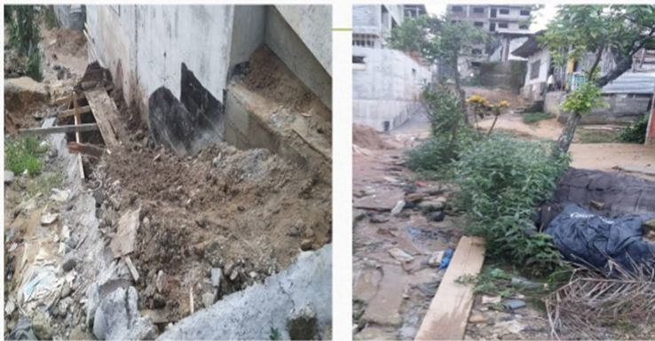
Image d'une ruelle avant travaux
