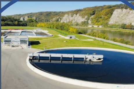
Traitement des eaux de process et des effluents
