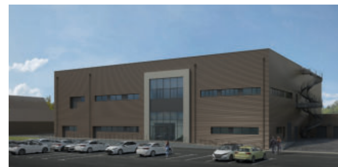
Laboratoire d'innovation sur les cellules de batterie Ampère (groupe Renault) – Lardy, France Projet clé en main, gestion de l'opération et création des périmètres du bâtiment
