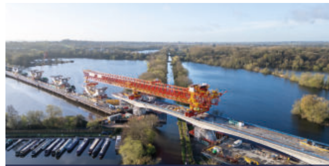
Viaduc HS2 Colne Valley – Royaume-Uni
