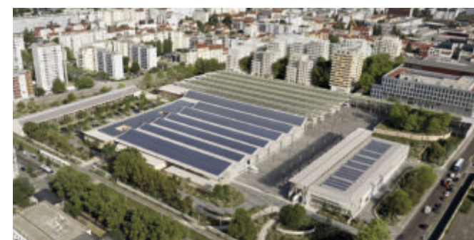
Centre de maintenance de Fagor à Lyon – France Ingénierie, conception et supervision de la construction, gestion des procédures réglementaires
