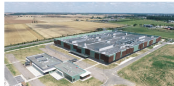
Centres de données Orange – France Conception et supervision de la construction
