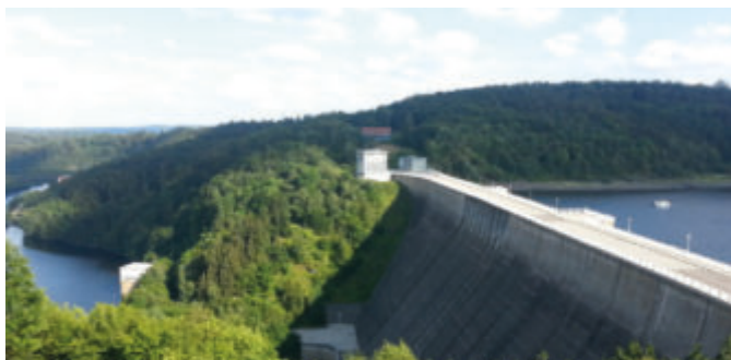
Barrage de Rappbode – Allemagne
