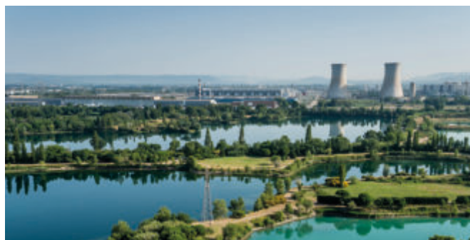
Projet Orano Pastel : installation de traitement des effluents d'uranium – France. Expertise en procédés nucléaires : analyse des technologies d'évaporation, dimensionnement, optimisation de l'efficacité énergétique et évaluation de la sécurité des technologies de filtration technologies de filtration
