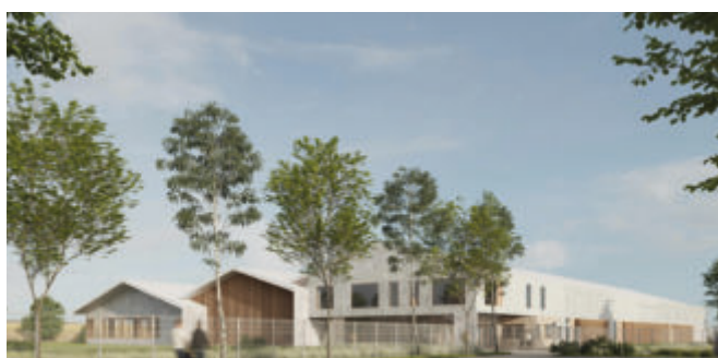
Construction d'une unité de production de produits de luxe MCGP – France Conseil technique en conception et construction, assistance au maître d'ouvrage
