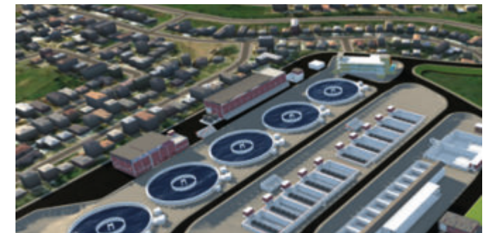
Projet d'approvisionnement en eau dans la partie inférieure de l'uMkomazi – Afrique du Sud Conception détaillée, ingénierie hydraulique et structurelle, appel d'offres
