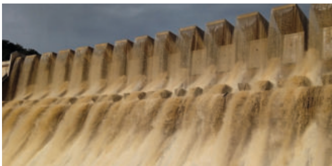
Barrage de Hazelmere – Afrique du Sud
