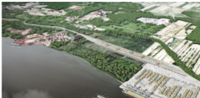
Terminal portuaire à conteneurs de Contrecoeur Canada
