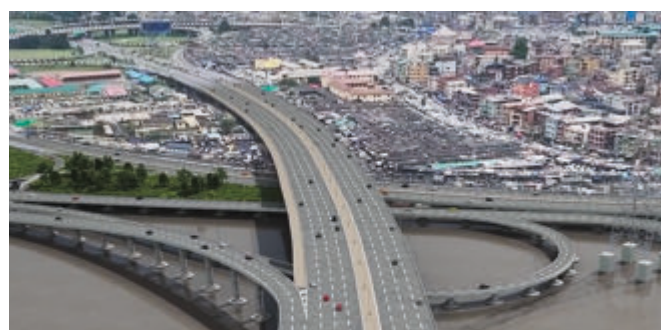
Autoroutes de la lagune de Lagos – Nigéria
