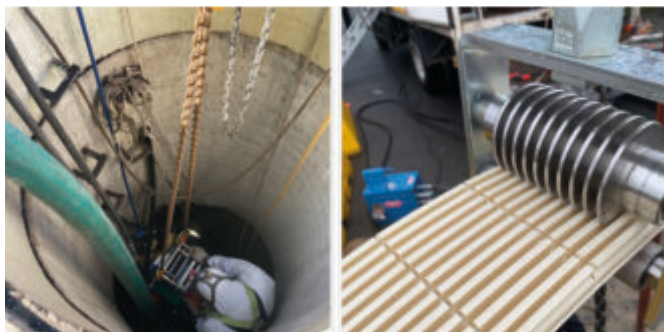
Réhabilitation des égouts des appartements du Cap Le Cap, Afrique du Sud Installation d'égouts gravitaires de plus de 14 km vers Cape Flats
