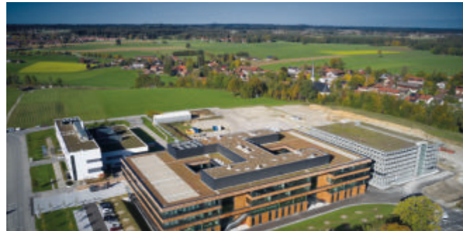
Bosch, nouveau centre de développement HK0202 Allemagne Plomberie, traitement de l'air, énergie, sprinklers, systèmes de gestion des bâtiments
