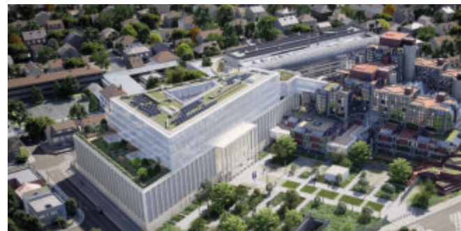
Agrandissement du tribunal de Bobigny – France Études techniques et conception, supervision de la construction
